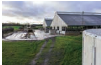
Όλα τα υγρά απόβλητα συγκεντρώνονται στη μία άκρη των σταβλικών εγκαταστάσεων.
