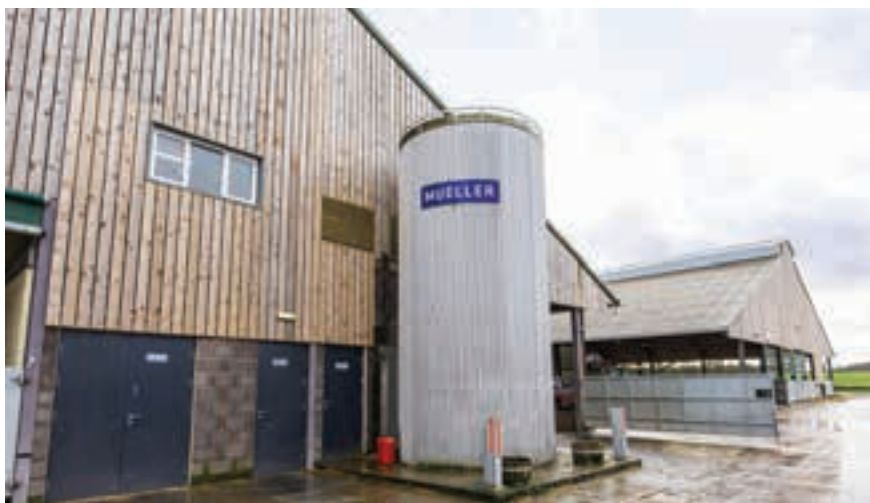
Μία δεξαμενή 30.000 λίτρων αποθηκεύει το φρέσκο γάλα και είναι τοποθετημένη έξω από το κτίριο για να διευκολύνει τη συλλογή.
