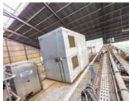
Οι μηχανολογικοί χώροι πάνω από τα κιβώτια των ρομπότ είναι για τους συμπιεστές και τις αντλίες κενού.
