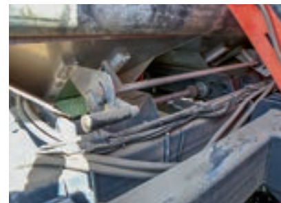
Το λίπασμα από τη δεξαμενή -χαλύβδινη κατασκευής- μετρίεται με τέσσερις ιμάντες.
