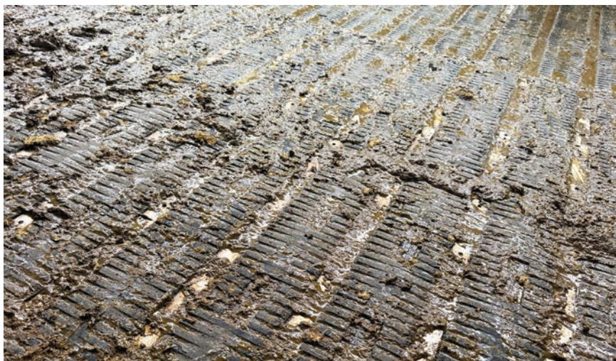
Τα κενά στις σχάρες γεμίζουν με ανοξείδωτο μέταλλο με τρύπες ανά 15 εκατοστά ώστε τα ούρα να μπορούν να αποστραγγιστούν στην αποθήκη που βρίσκεται κάτω από το δάπεδο που φαίνεται στη φωτογραφία.
