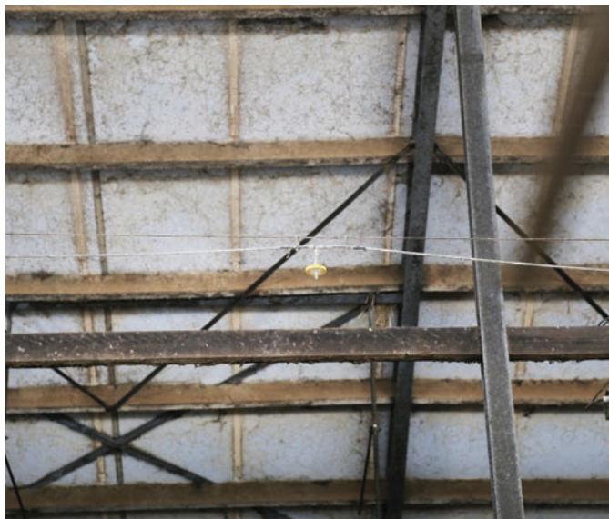
Η φάρμα van Adrichem είναι μέρος ενός project που μετρά την αμμωνία, το μεθάνιο και επίπεδα CO 2 του αχυρώνα. Κίτρινοι αισθητήρες στην οροφή κάνουν τη μέτρηση.
