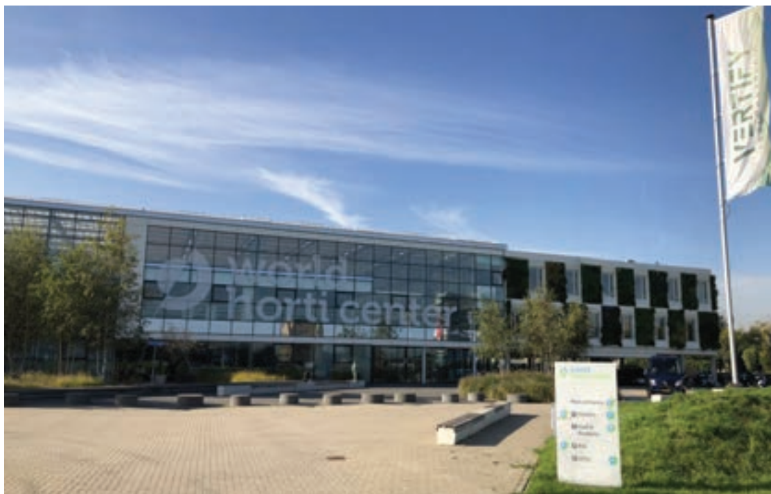
Το Κέντρο Καινοτομίας και Εκθετήριο Αγροτικών Προϊόντων και Υπηρεσιών, «World Horti Center» στο Naaldwijk της Νότιας Ολλανδίας, όπου «ανθούν» θερμοκήπια παραγωγής κηπευτικών και λαχανικών.
