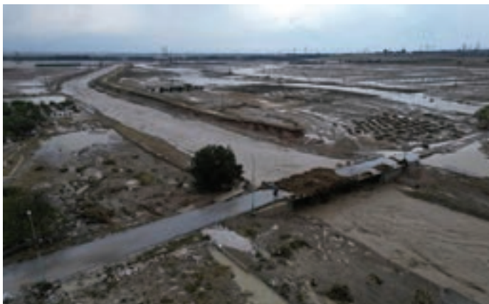
Σε πολύ λίγες περιπτώσεις δυστυχώς παρατηρήθηκε και φωτογραφήθηκε χαραδροειδής διάβρωση.
