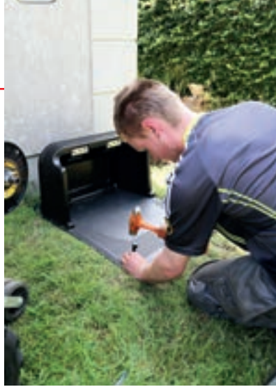
Το σημείο φόρτισης πρέπει να βρίσκεται σε επίπεδη επιφάνεια και να διατηρείται στη θέση του από πλαστικά πασσαλάκια.
