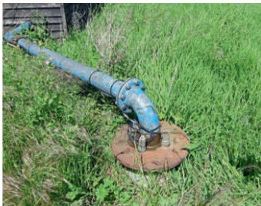
Οι Pilgrim διαθέτουν μια κύρια αντλία στο κάτω μέρος της γεώτρησης και μια βοηθητική αντλία. Ένα σύγχρονο σύστημα θα χρησιμοποιούσε μόνο τη μία.
