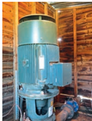
Οι Pilgrim διαθέτουν μια κύρια αντλία στο κάτω μέρος της γεώτρησης και μια βοηθητική αντλία. Ένα σύγχρονο σύστημα θα χρησιμοποιούσε μόνο τη μία.
