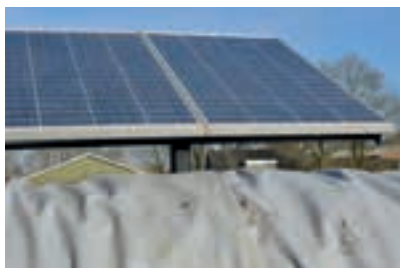
Ηλιακοί συλλέκτες φορτίζουν τις μπαταρίες, αλλά το σύστημα μπορεί να συνδεθεί και στο δίκτυο.
