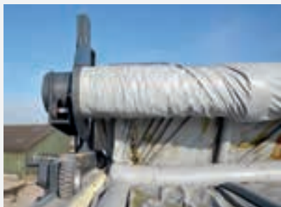
Οι τροχοί κινούνται πάνω σε ράγες και ασφαλίζονται, στην κορυφή της τάφρου.
