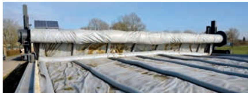
Με απόσταση μεταξύ τους τα 2 μέτρα, τα λάστιχα με νερό έχουν διάμετρο 190 χιλιοστά.
