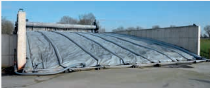
Το στενότερο σύστημα Easy Silage που έχει εγκατασταθεί μέχρι τώρα, ήταν για μια τάφρο πλάτους 8 μέτρων, ενώ η πιο πλατιά ήταν 16 μέτρα. Η εταιρεία θεωρεί πως το μέγιστο πλάτος μπορεί να φτάσει τα 25 μέτρα.
