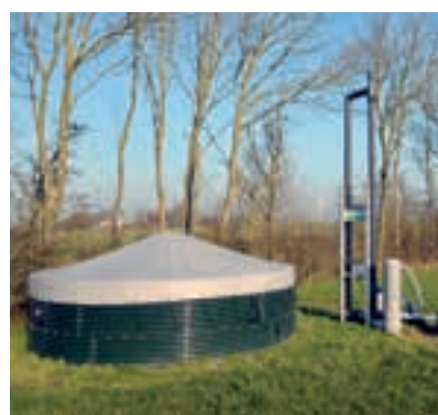
Καθώς το κάλυμμα απομακρύνεται, τα λάστιχα νερού αδειάζουν αυτόματα σε μια δεξαμενή.
