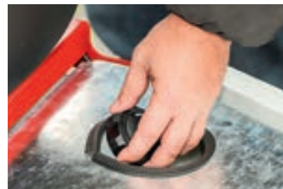
Θέσαμε το θέμα με τις αιχμηρές, άκρες στο καπάκι της δεξαμενής και τοποθετήθηκε μια προστασία.
