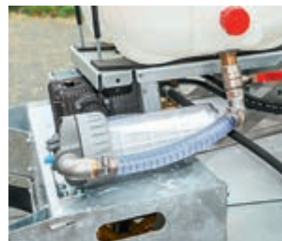
Η πλατφόρμα για την απάντληση της δεξαμενής.
