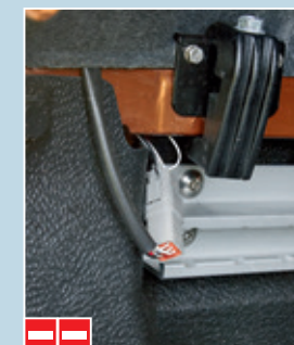
Το εκτεθειμένο βύσμα στο χώρο φόρτωσης είναι εύκολο να πάθει ζημιά.
