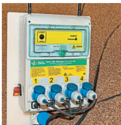
Οι ανεμιστήρες ενεργοποιούνται από ένα ειδικό χειριστήριο που συνδέεται με ασύρματο, το οποίο λαμβάνει εντολές από τη μονάδα. Αυτό διαχειρίζεται τέσσερις ανεμιστήρες.
