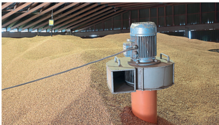
Η μονάδα Pile-Dry είναι ένα από τα πολλά συστήματα εξαερισμού/στεγνώματος που μπορεί να ελέγξει το Barn Owl Wireless.
