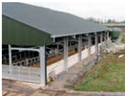
Με κλίση 20° η οροφή είναι πιο απότομη απ' ό,τι συνήθως για να παραμένει καθαρή και να αεριζείται καλά ο χώρος ενσταβλισμού.
