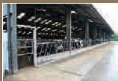
... ενώ για τις ευθείες διαδρομές, όπως για παράδειγμα κατά μήκος του φράκτι τροφοδοσίας, το καλώδιο καθοδήγησης φωλιάζει σε μια σχισμή στο σκυρόδεμα.
