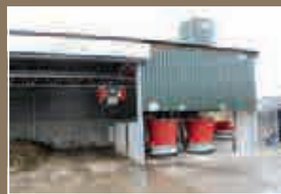
Ένα νέο βόθους 10 μέτρων και πλάτους 25 μέτρων κτίριο κατασκευάστηκε για να στεγάσει τον χώρο τροφοδοσίας και τον χώρο στάθμευσης του συτήματος Vector.
