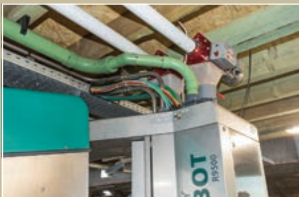
Για την απλοποίηση της επίλυσης προβλημάτων, οι σωλήνες για το νερό, το υγρό εμπότισης και τον πεπιεσμένο αέρα έχουν άλλα χρώματα.
