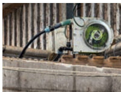
Τα ούρα αντλούνται από μια περισταλτική αντλία και μεταφέρονται στην κλειστή αποθήκη.
