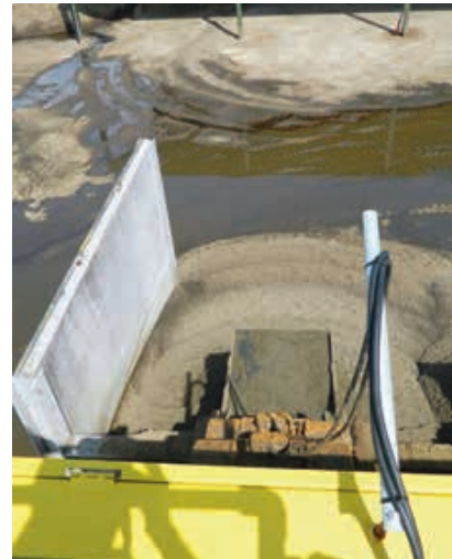
Οι αναδευτήρες βοηθούν στην άντληση νερού.
